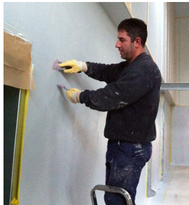
5. EVENTUEEL SCHEUREN REPAREREN
